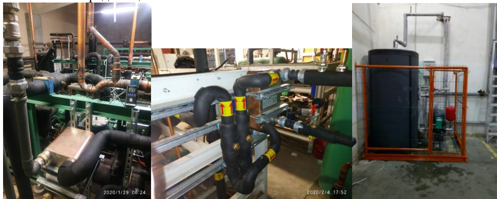
Рис.1. Розміщення пластинчастих теплообмінників та акумуляційного бака
