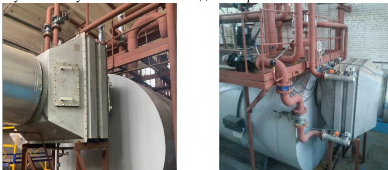
Рис. Вигляд теплоутилізатора встановленого на жаротрубному котлі потужністю 10 МВт
